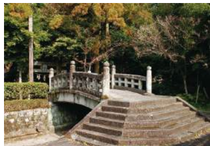
多氣坂本神社の石の太鼓橋
